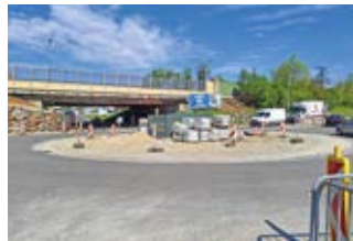
Beim Kreisverkehr in der Gradnerstraße wird gearbeitet.
