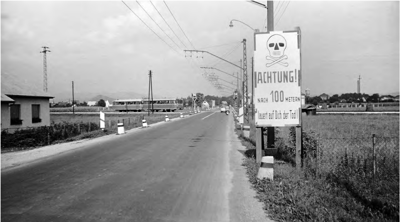
Im Jahr 1964: Der Rote Blitz quert mit unverminderter Geschwindigkeit die Kärntner Straße. Sechs Jahre später wurde hier auf der „grünen Wiese“ die Station Webling errichtet. Wegen der Verkehrszunahme war hier der Bau eines sicheren Gehsteiges notwendig geworden. Durch die zu nahe an der Fahrbahn stehenden Masten der Oberleitung war dies nicht möglich und somit wurde der O-Bus-Betrieb eingestellt. Links das erste Werkstattgebäude der Fa. Paar.
